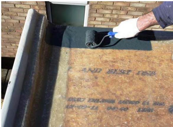
Top edge onto deck
